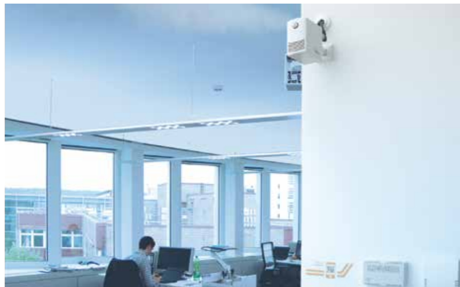
Kontorslandskap på Fraunhofer IAO med aktiv luftbefuktning
